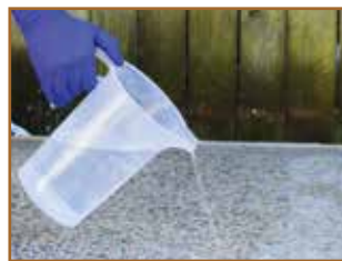
Pour acid mix onto surface.
